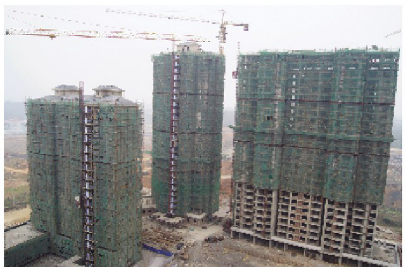
图为14#、17#、18#楼结构封顶
